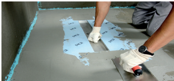
Verbundabdichtung nach DIN 18534
